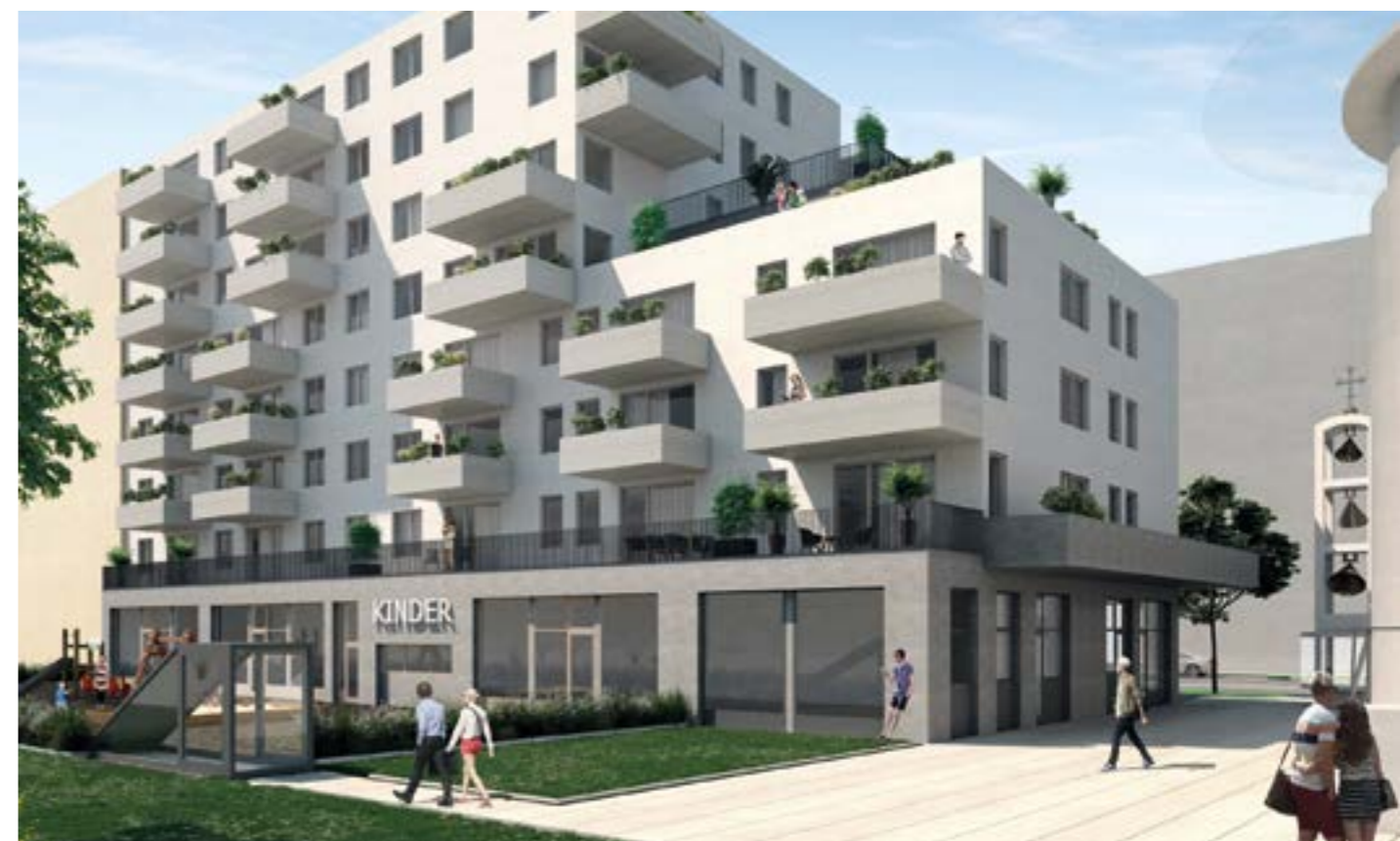
Nordbahnhof, Baldassion Architektur © Stadt Wien, Wiener Wohnen
